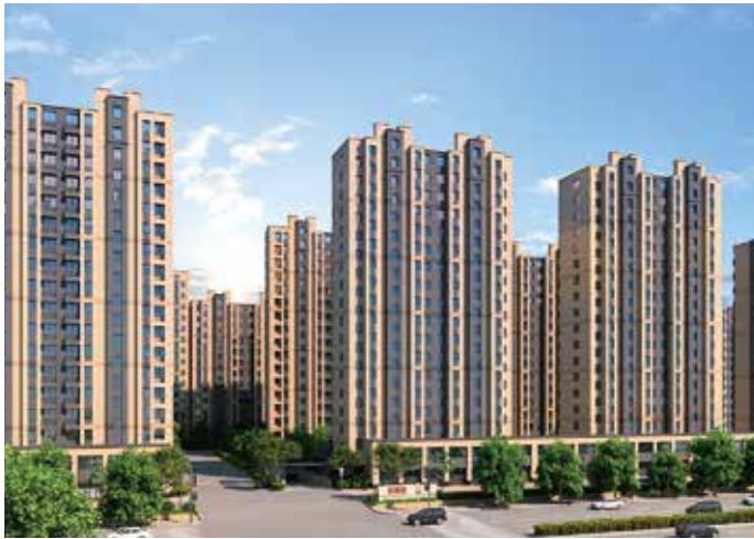
庄桥街道李家安置房项目 浙江
